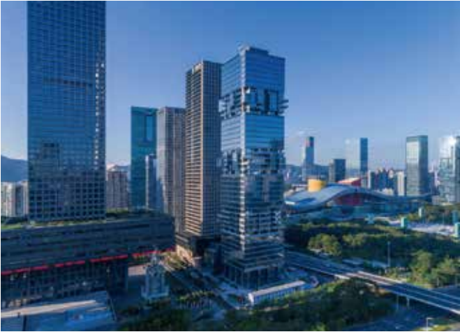
“基金大厦”实景图
