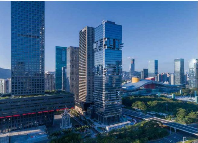
“基金大厦”实景图
